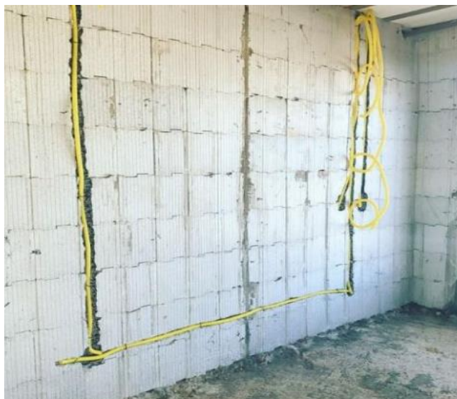
Figura 10 – Instalação elétrica embutida na fôrma
