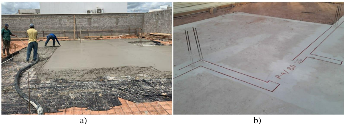
Figura 5 – a) Execução de radier; b) Marcação das paredes
