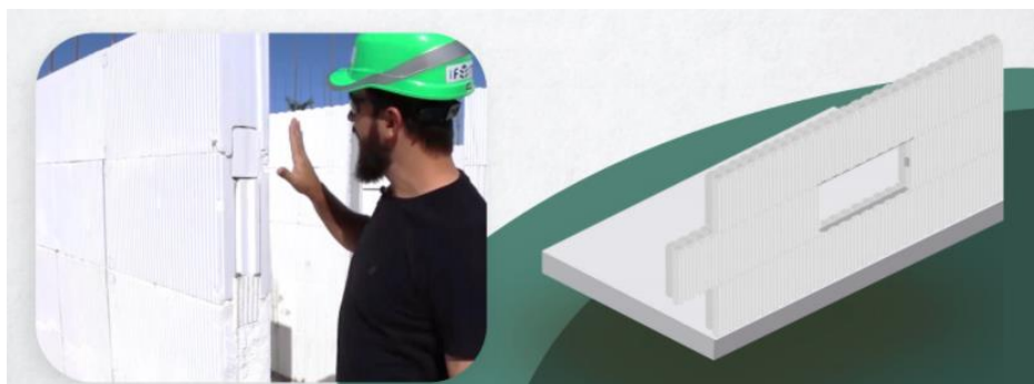
Figura 9 - Fechamento das vigas horizontais
