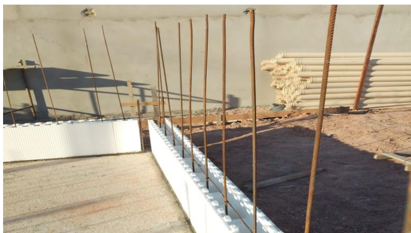
Figura 6 – Ancoragem das fôrmas de EPS e posicionamento das barras
