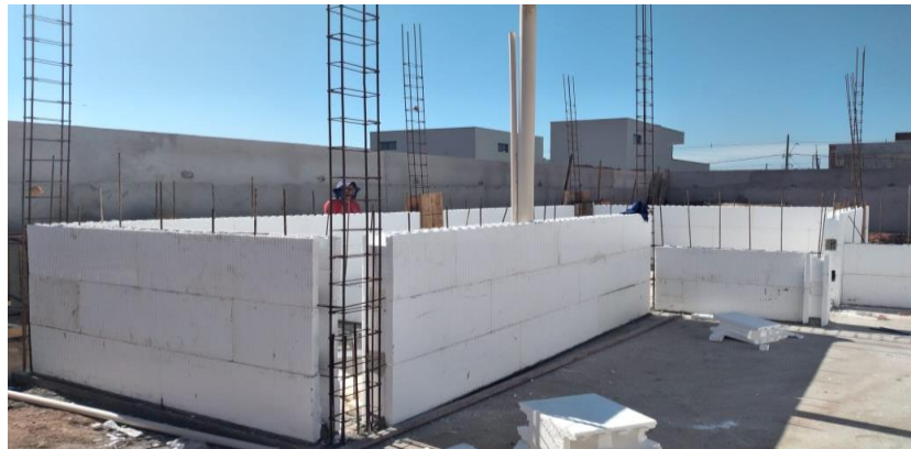
Figura 8 – Execução do sistema ICF
