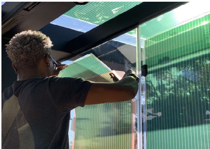
Figura 8 – Aplicação de película semitransparente em superfície de vidro de edifício.
