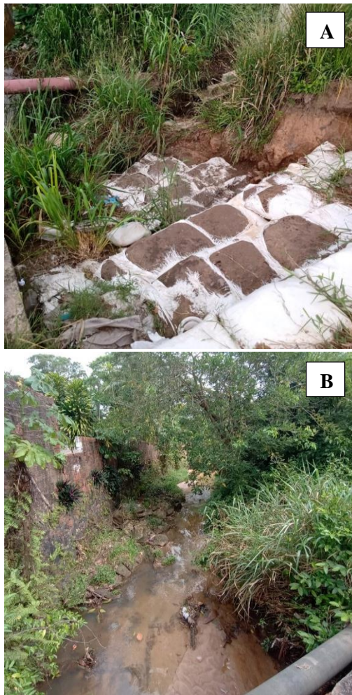
Figure 14. Imagem A – Estrutura de enrocamento no médio curso do rio Calhau; Imagem B – Influência da erosão das margens no médio curso do rio Claro
