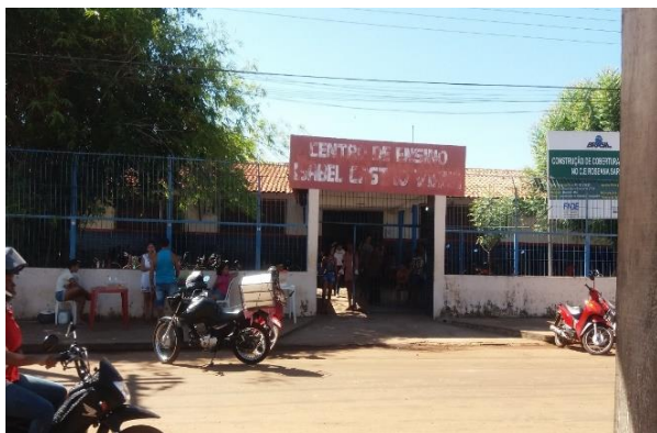
Figura 1: Faixada da Escola
