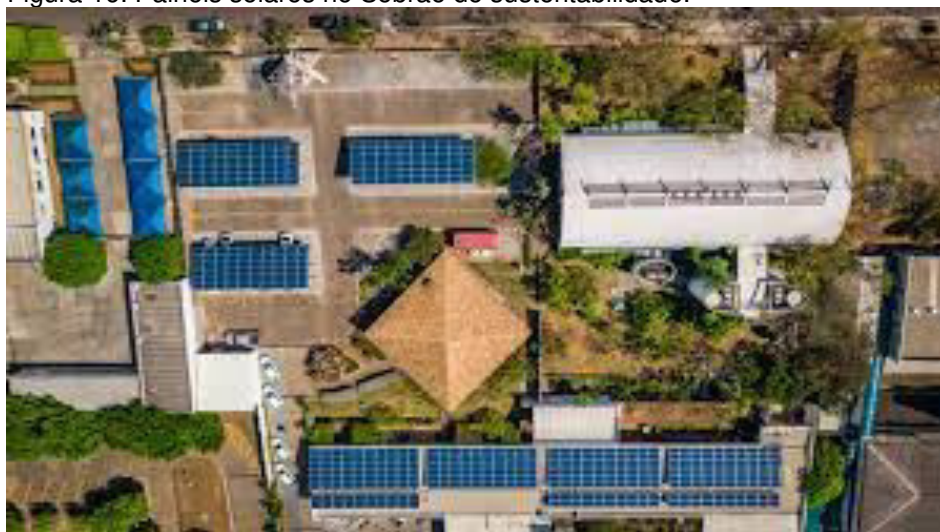
Figura 16: Painéis solares no Sebrae de sustentabilidade.
