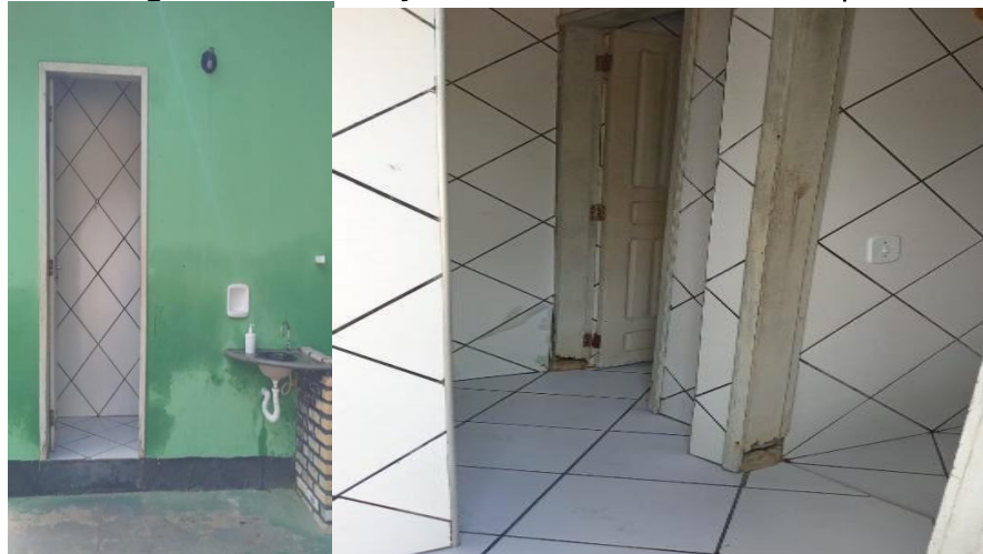
Figura 14- Instalações sanitárias-banheiros e pia
