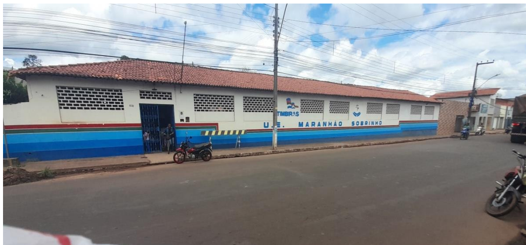
FOTO 1 - Fachada da escola
