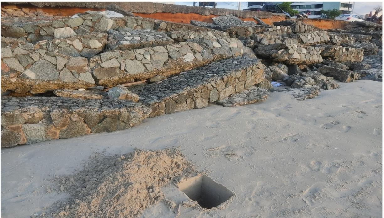
**Figura 30.** Enrocamentos degradados por conta da erosão presentes na Praia da Ponta d' Areia.
