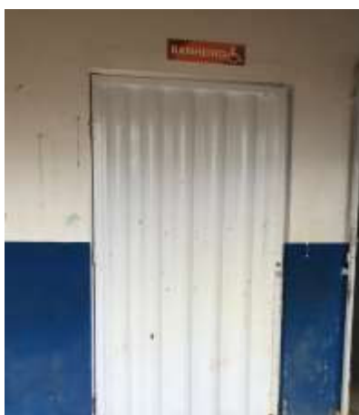
Figura 19: Porta do sanitário.
