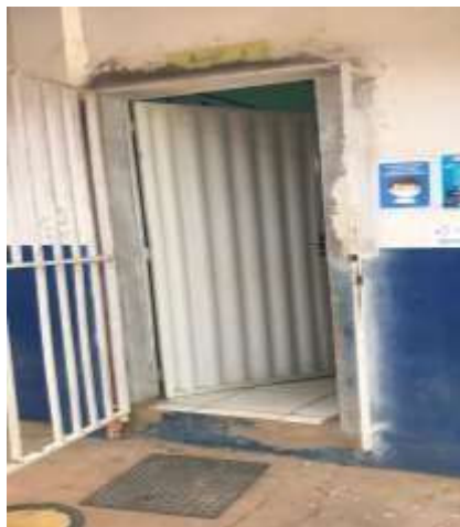
Figura 16: Porta de acesso a biblioteca
