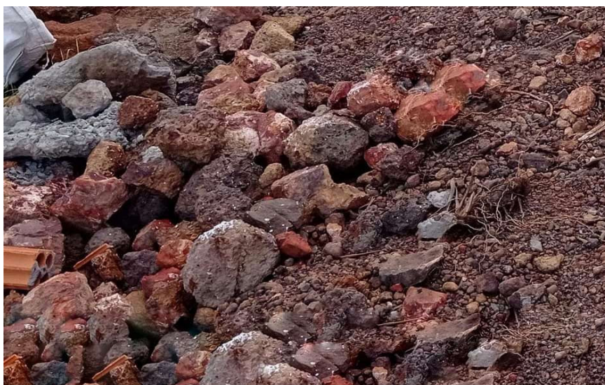
Figura 10 – Área de depósito provisório dos resíduos classe A.
