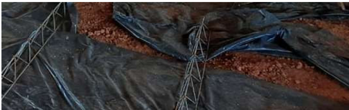
Figura 6 - Uso de lona para impermeabilização do solo.
