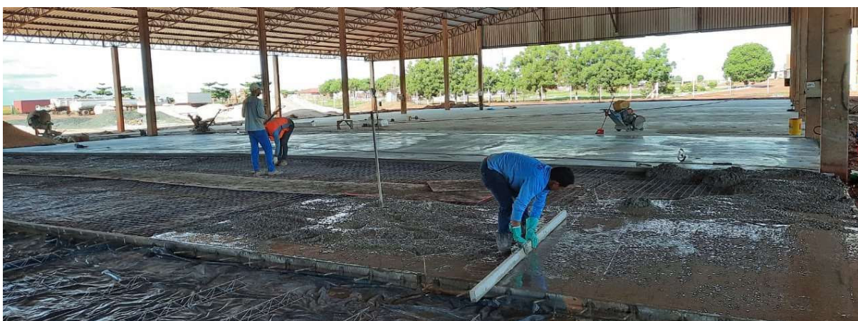
Figura 8 - Lançamento e adensamento do concreto
