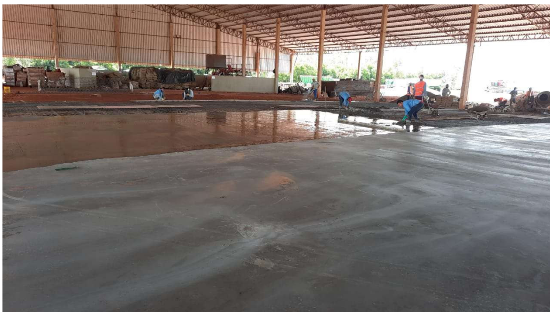
Figura 9 - Nivelamento e acabamento superficial
