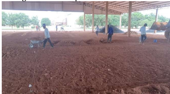
Figura 5 A - Limpeza manual do terreno.
