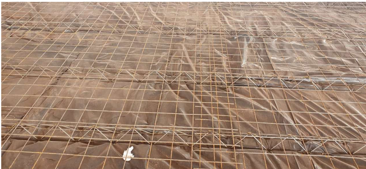
Figura 7 - Execução de armação das ferragens
