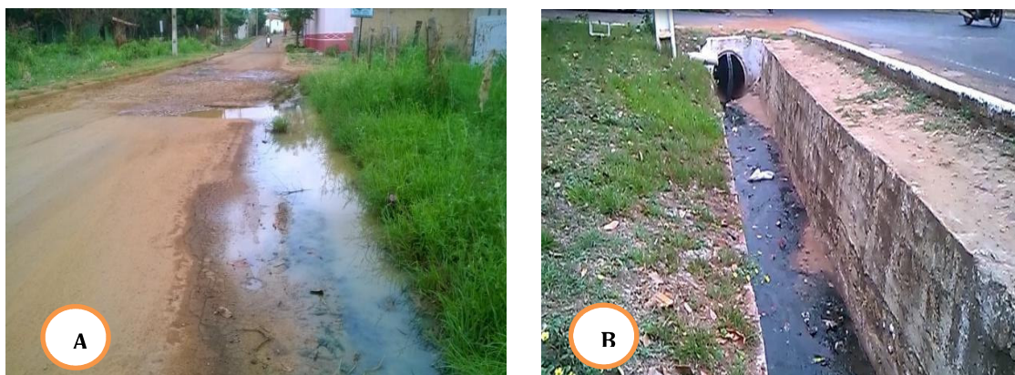
Figura 4. A - Esgoto a céu aberto localizado no Bairro Extrema na cidade de Grajaú/MA. B – Escoamento de esgoto localizado no perímetro da BR 226 despejado diariamente no Rio Grajaú.
