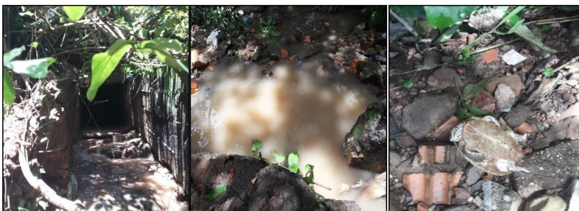
Figura 06. Esgoto nas proximidades de residências e lava jato no bairro Rodoviária. Fonte: Acervo particular
