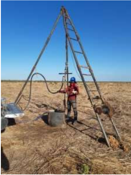
Figura 8 - Execução da sondagem do SPT 01 no dia 18/08/2021
