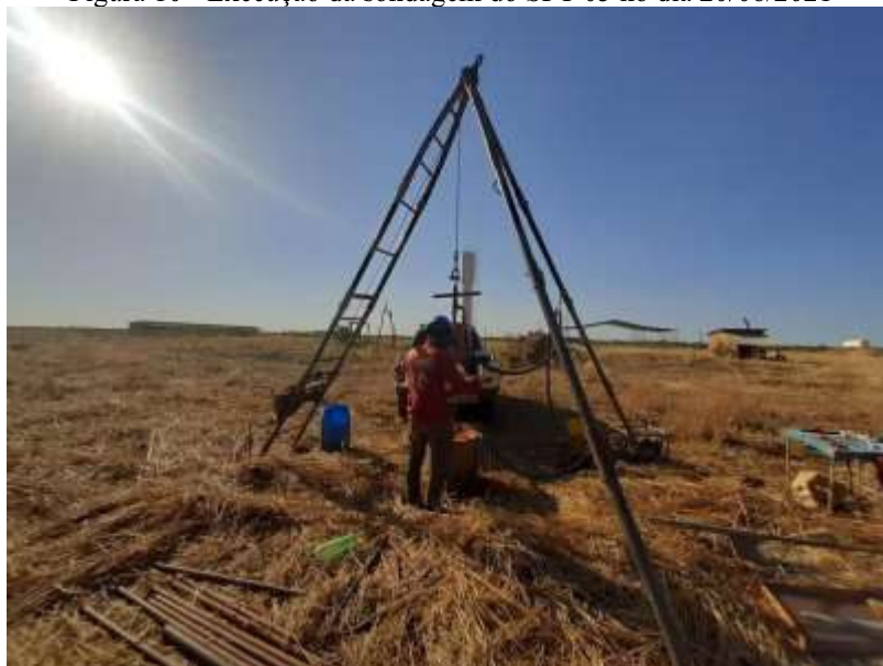
Figura 10 - Execução da sondagem do SPT 03 no dia 20/08/2021
