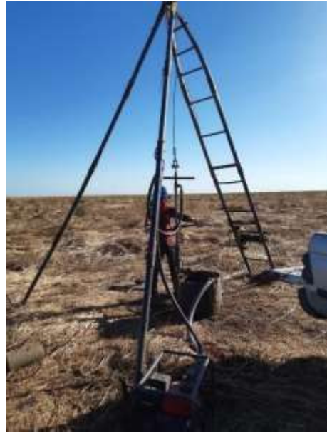
Figura 9 - Execução da sondagem do SPT 02 no dia 19/08/2021
