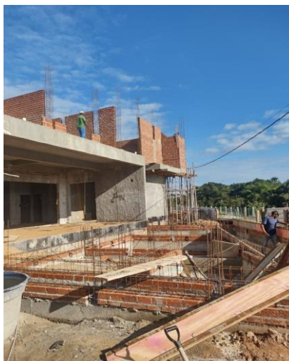
FIGURA 8: Obra em andamento.
