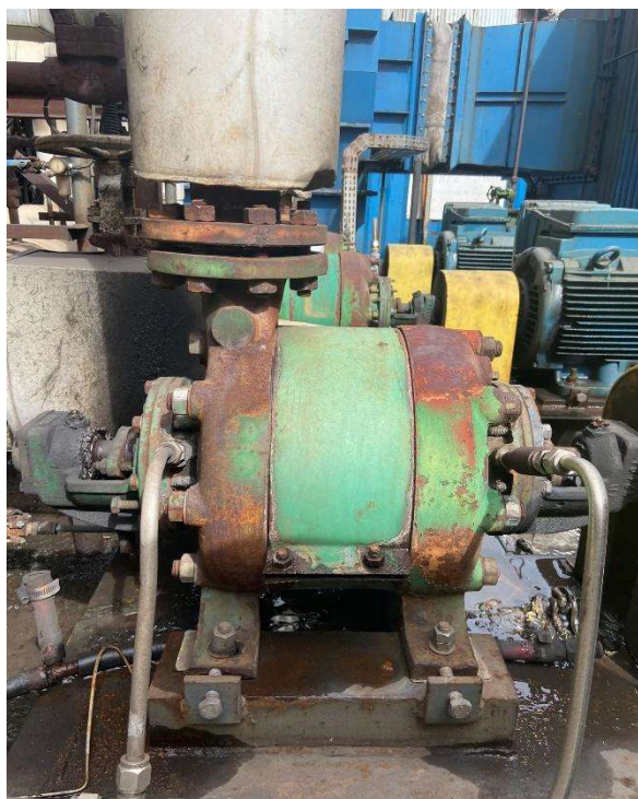
Figura 24 - Bomba centrífuga multiestágio WK 65/3.
