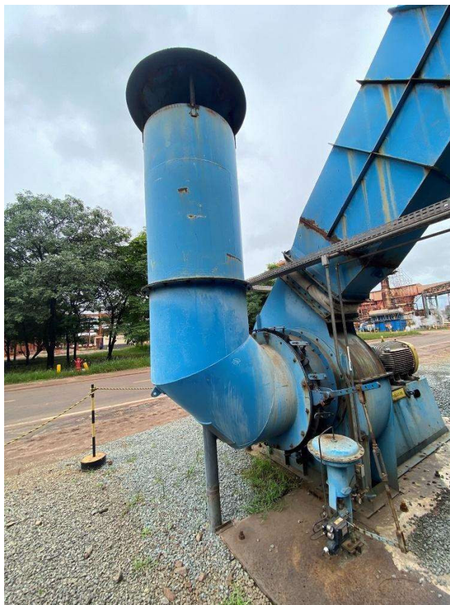
Figura 26 - Ventilador Marelli com damper externo.
