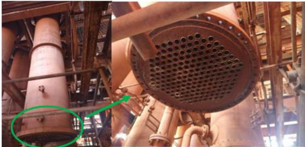
Figura 3: Trocador de calor tubular utilizado em uma planta de produção de alumina. Fonte: Adaptado por autora (2022).
