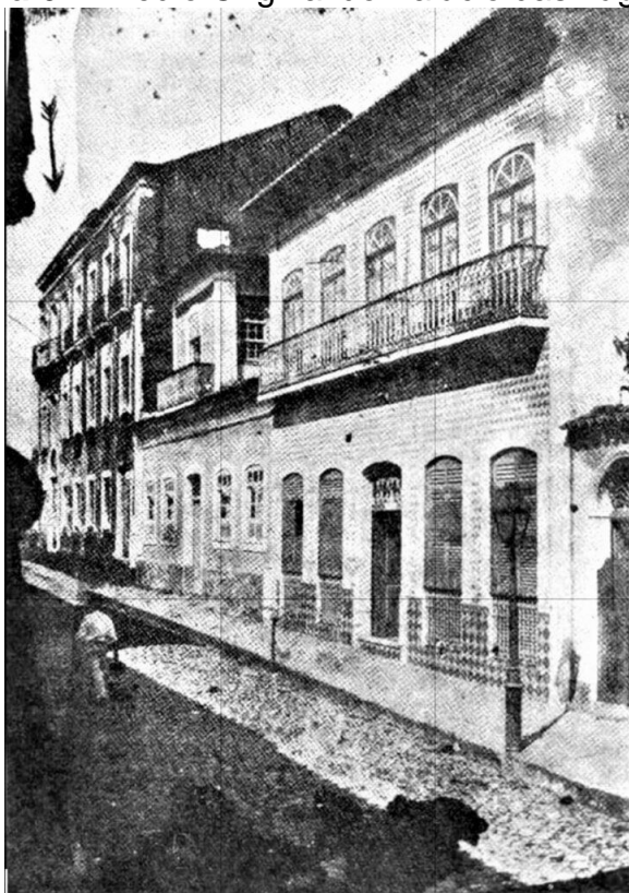
Figura 61: Prédio Original do Palácio das Lágrimas
