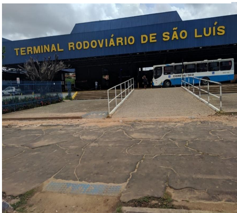
Figura 5 - Fachada do TRSL
