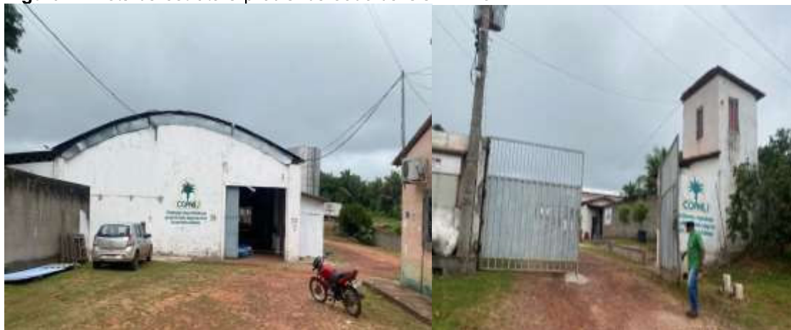
Figura 4: Vista da estrutura predial da sede da COPPALJ
