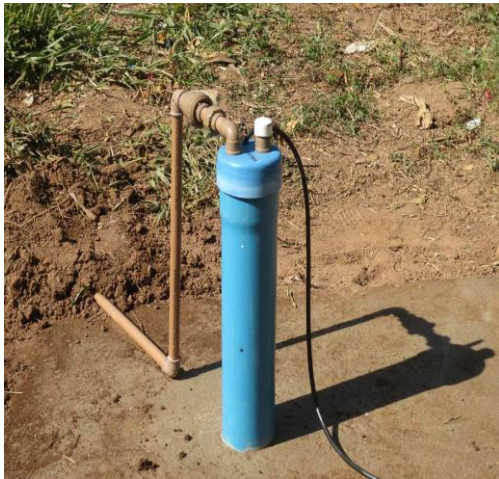
Figura 2: (a) Poço artesiano instalado e já em uso
