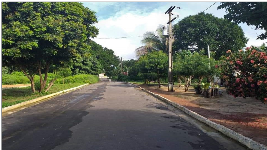
Figura 07 – Pavimentação das ruas na comunidade São José dos Mouras (2020)
