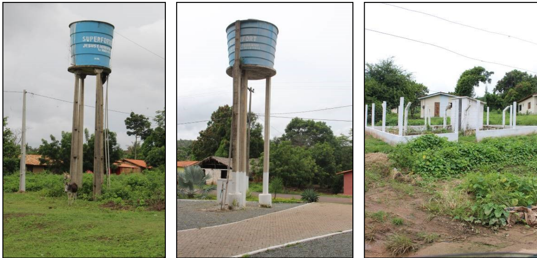
Figura 04, 05 e 06 – Sistemas de Abastecimento de água do Projeto de Assentamento Riachuelo (2020)
