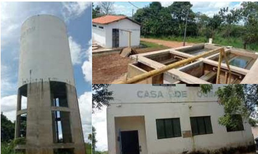
Figura 2: Estação de Tratamento da CAEMA Timbiras-MA
