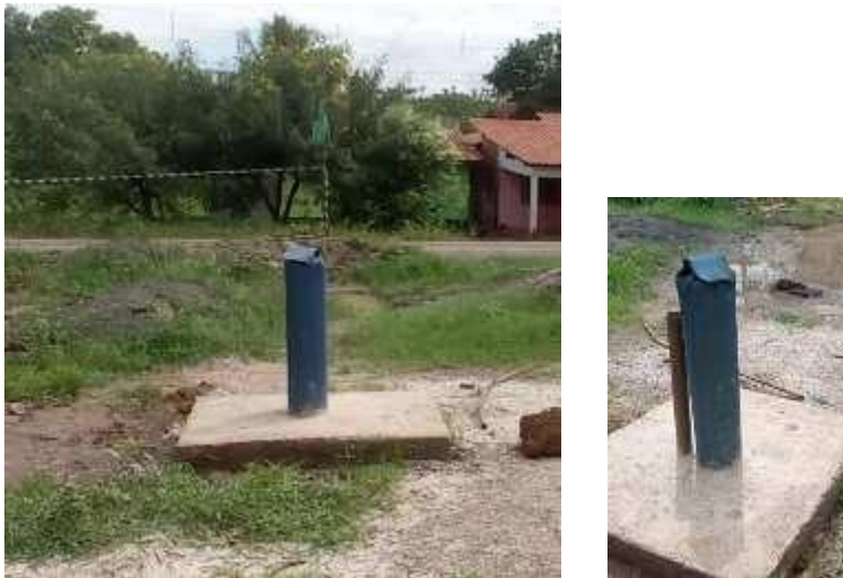
Figura 11: Poço do Bairro Anjo da Guarda
