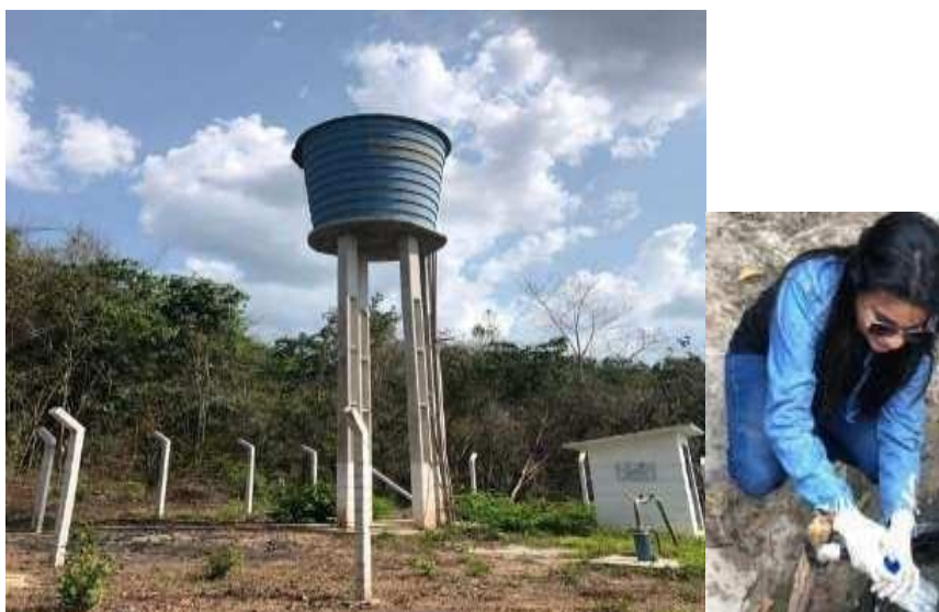
Figura 7: SAA do Povoado Jacaré do Acelino: 40 residências abastecidas
