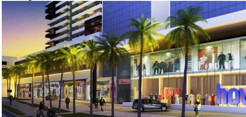
Figura 6 – Condomínio misto em São José, Santa Catarina
