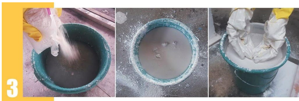
Figura 47 - Passo 3: Preparação do gesso.
