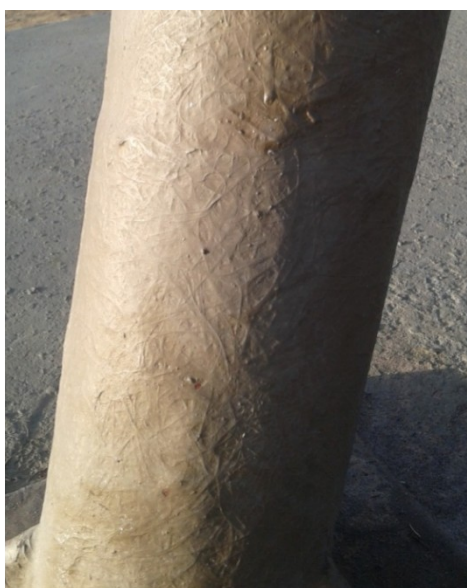
Figura 61: Camada de fibra de vibro na estrutura do marco.
