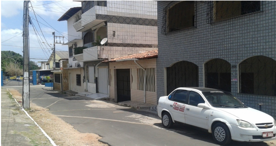
Figura 54: Vista das casas da vila em frente à entrada da Uninassau e suas fachadas. Fonte: Da autora.
