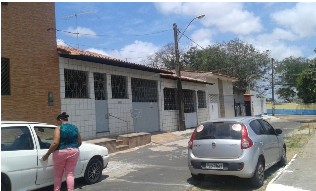
Figura 55: Vista das casas da vila e suas fachadas. Fonte: Da autora.
