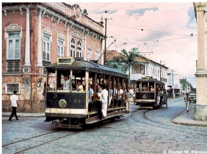
Figura 7 – Bondes Elétricos na Rua Rio Branco com esquina da Rua da Paz
