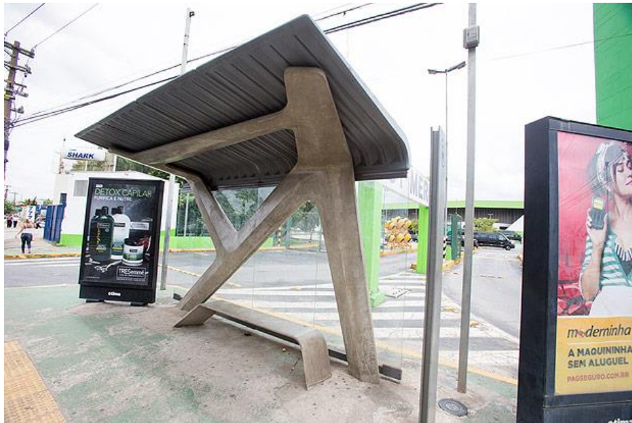
Figura 27 – Abrigo em ponto de ônibus na marginal Tietê
