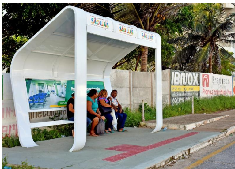
Figura 22 – Implantação de abrigo na Av. Colares Moreira
