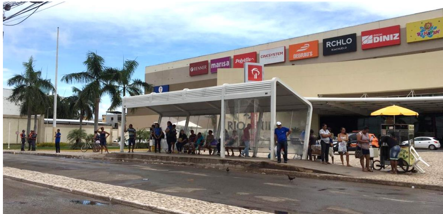
Figura 24 – Abrigo na avenida São Luís Rei de França
