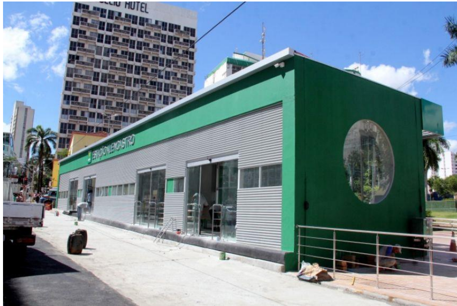
Figura 35 – Estação Alencastro em Cuiabá - MT
