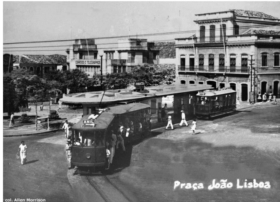
Figura 9 - Abrigo da praça João Lisboa
