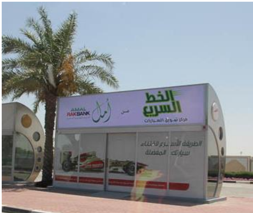
Figura 12 – Abrigo de ponto de ônibus em Dubai - Emirados Árabes
