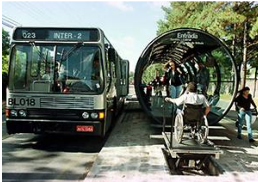
Figura 59 – Acesso por elevadores na Estação Tubo
