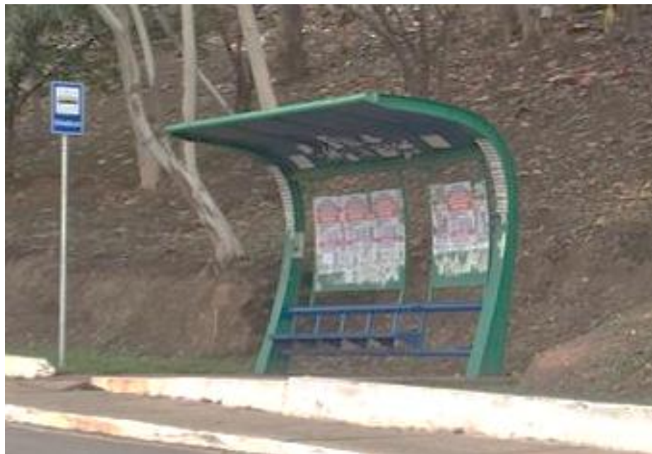
Figura 19 - Abrigo com estrutura em ferro galvanizado
