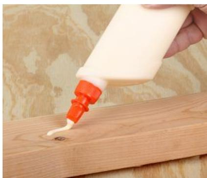
Figura 25 - Cola de PVA em superfície de madeira
