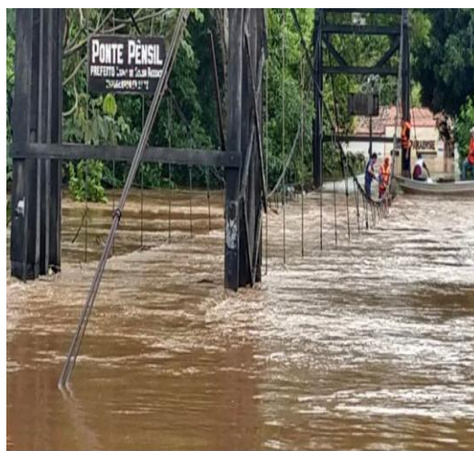
Figura 10 – inundação Rio Grajaú
