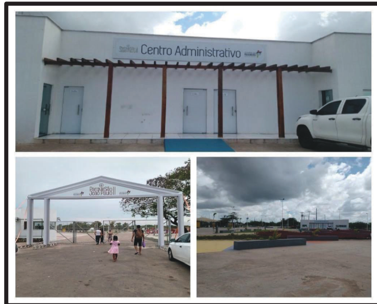
Figura 49 – Centro administrativo, banheiros e entrada principal Fonte: AUTORA, (2022)
