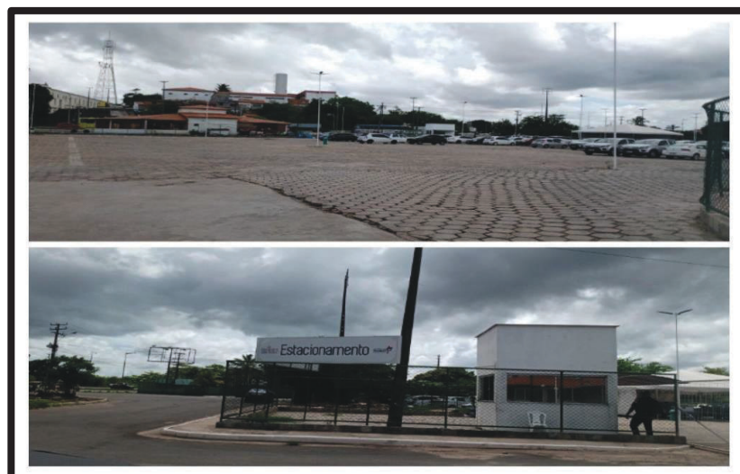
Figura 48 - Estacionamento Fonte: AUTORA, (2022)
