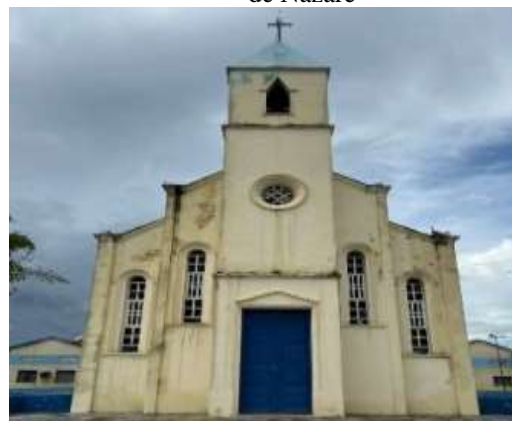
Figura 11 - Fachada frontal da Igreja Nossa Senhora de Nazaré
