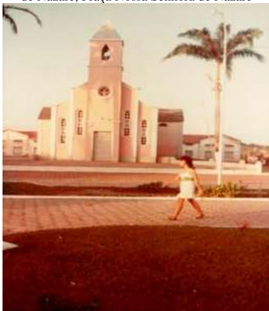
Figura 16 - Registro da Igreja Matriz Nossa Senhora de Nazaré, Praça Nossa Senhora de Nazaré
