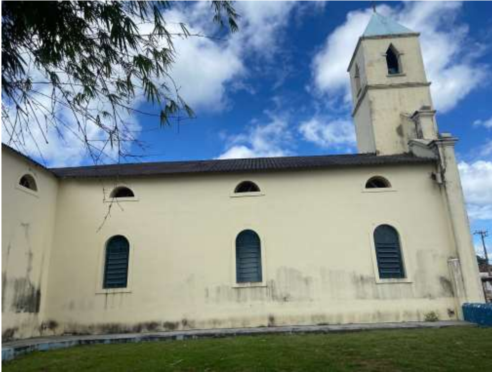
Fachada lateral esquerda
