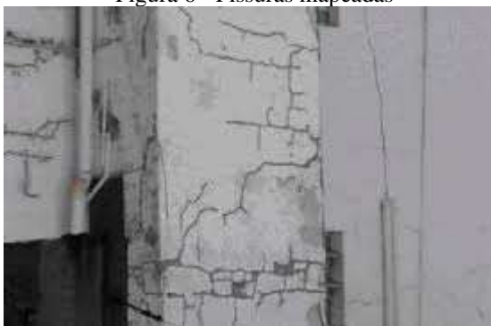
Figura 6 - Fissuras mapeadas
