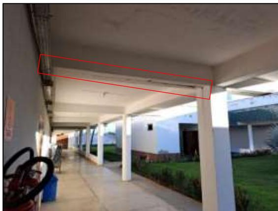
Manifestação localizada na viga em frente ao laboratório de materiais de construção civil no prédio dos laboratórios, essa manifestação ocorre na junta de dilatação
