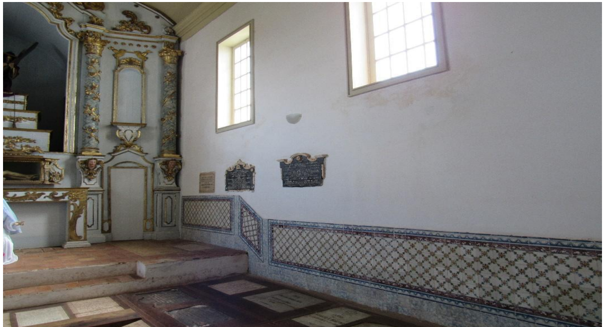
Figura 22: Visão geral da parede lateral direita da Capela.
