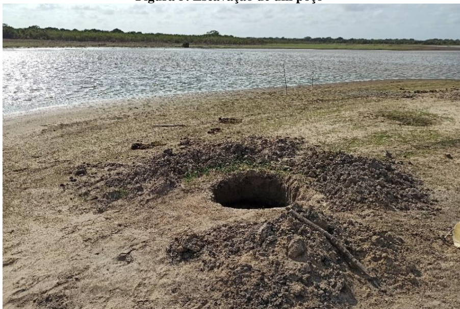
Figura 5: Escavação de um poço
