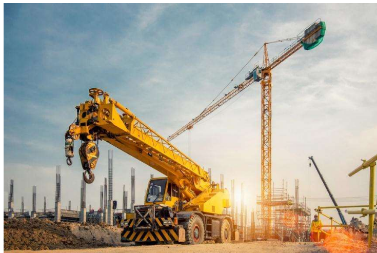
Figura 1 - Guindastes na construção civil
