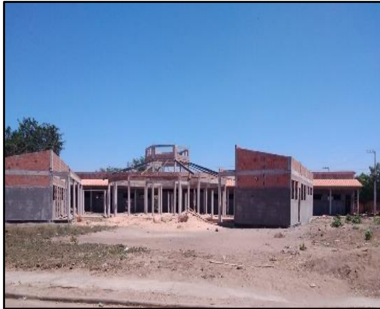
Figura 178: Construção da escola
