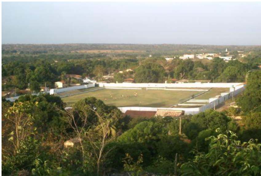
FIGURA 1 – ESTÁDIO MUNICIPAL DE SÃO BERNARDO – MA
