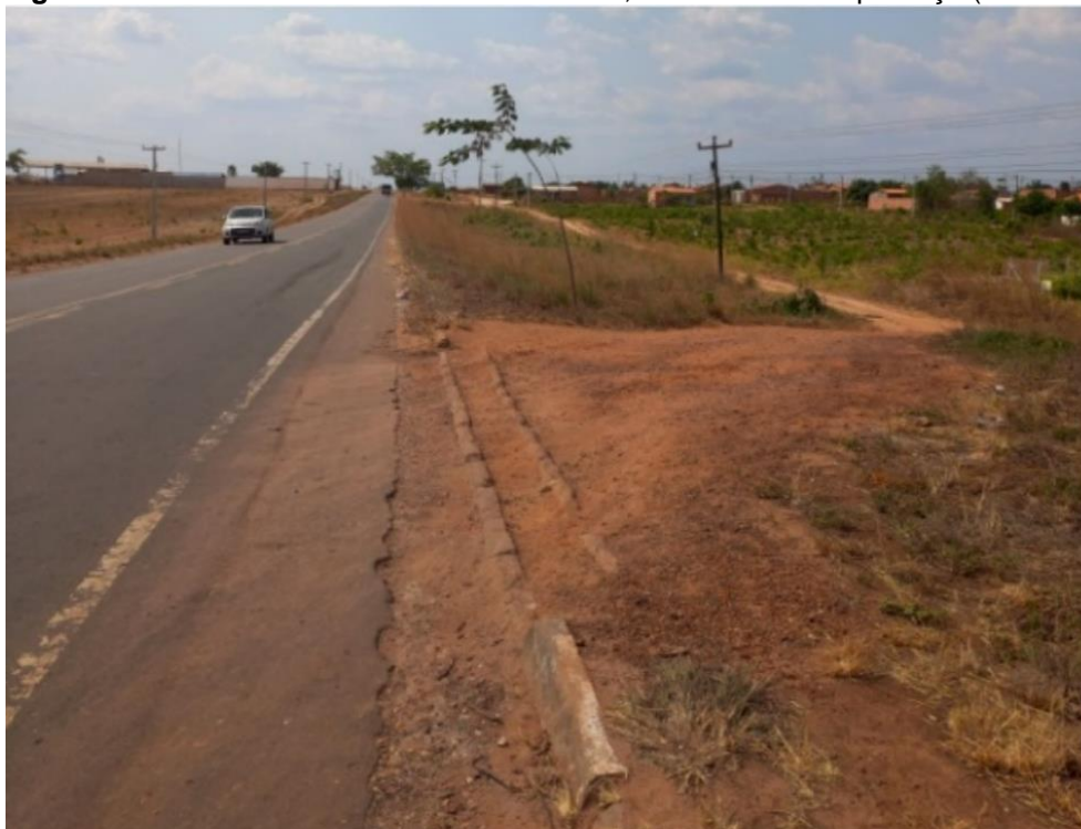
Figura 9 - Acesso à Rua Dimas de Matos Lima, no bairro Vila Esperança (MA 006)
