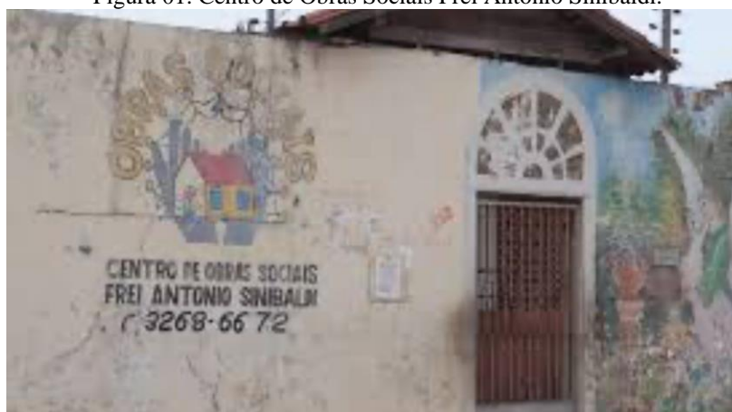
Figura 01. Centro de Obras Sociais Frei Antônio Sinibaldi.
