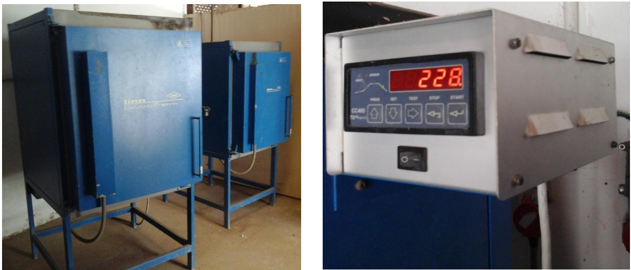
Figura 15 - Em seqüência, forno elétrico e painel de controle dos programas de queima.
