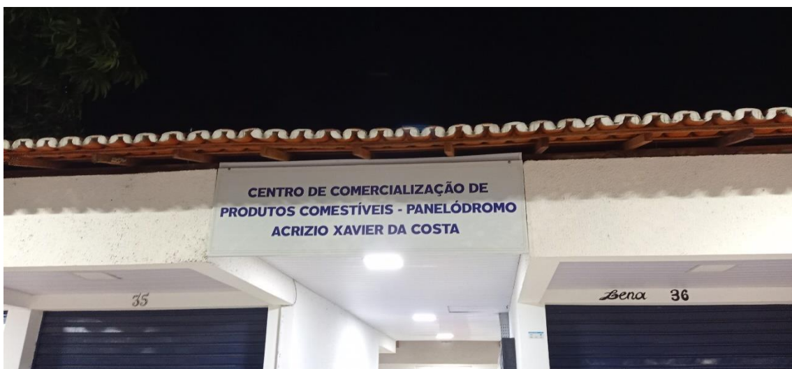
Fig. 9: Detalhes do novo panelódromo
