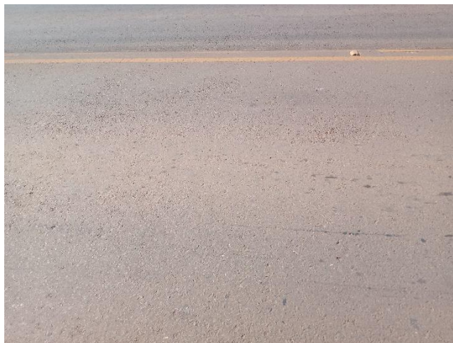
Figura 47 – Desgaste da Seção 13.
