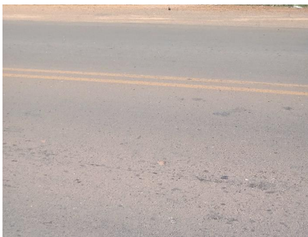
Figura 44 – Desgaste na Seção 11.
