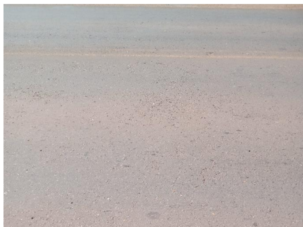
Figura 35 – Desgaste da Seção 3.
