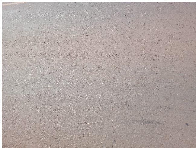
Figura 37 – Desgaste da Seção 5.
