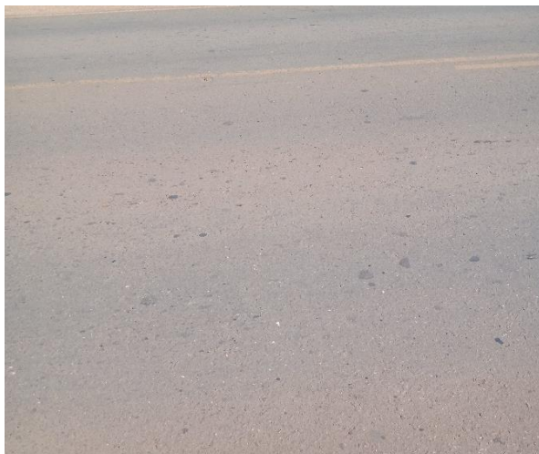
Figura 36 – Desgaste da Seção 04.
