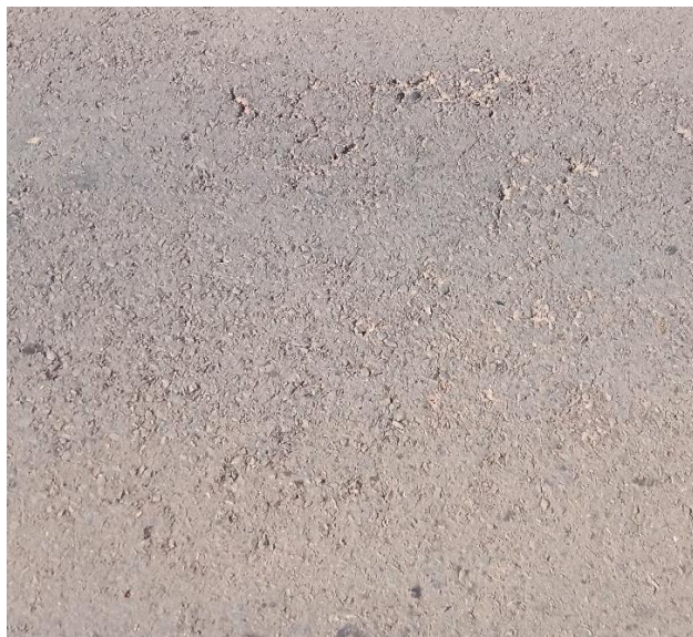
Figura 51 – Couro de jacaré da Seção 17.
