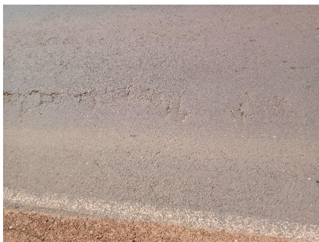
Figura 34 – Couro de jacaré na Seção 3.
