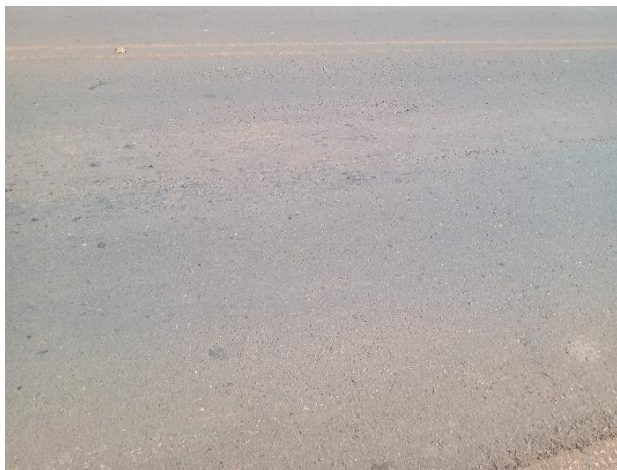
Figura 45 – Desgaste da Seção 12.
