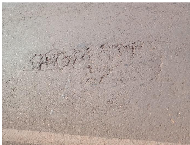
Figura 49 – Couro de jacaré da Seção 15.
