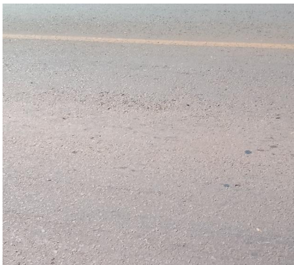
Figura 40 – Desgaste da Seção 8.
