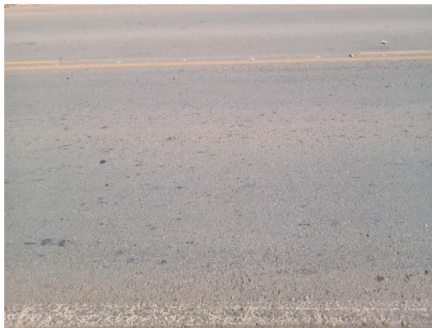
Figura 48 – Desgaste da Seção 14.
