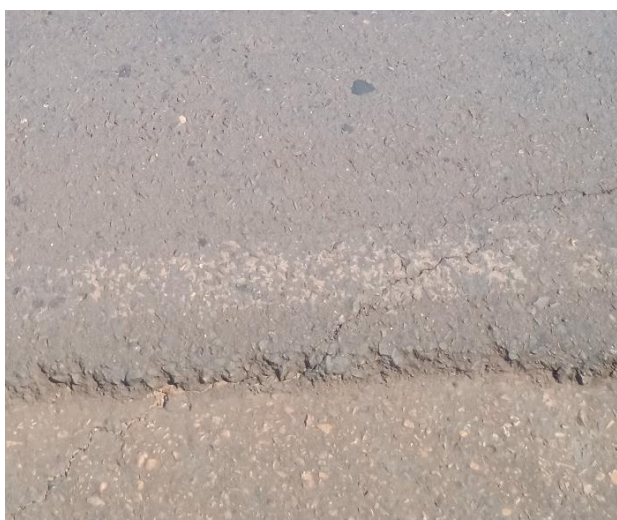
Figura 33 – Fissuras Longitudinais.
