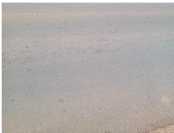
Figura 43 – Desgaste na Seção 10.
