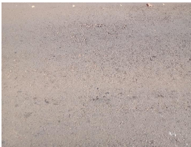
Figura 50 – Desgaste da Seção 16.
