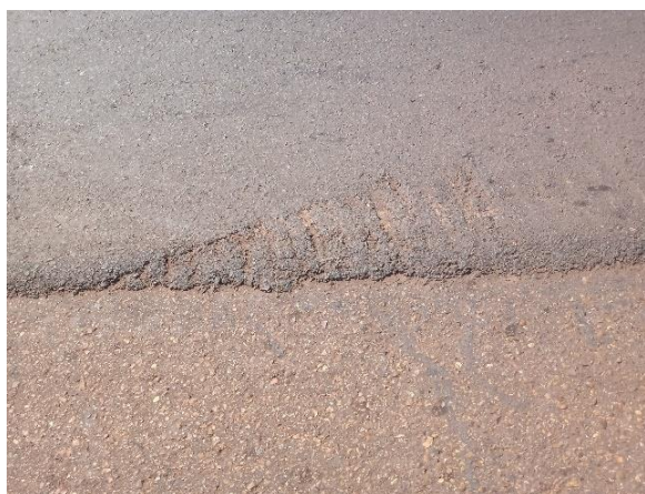
Figura 38 – Afundamento da Seção 6.
