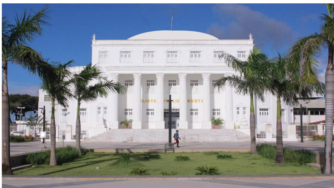
Foto 1 – Prédio onde funciona a BPBL
