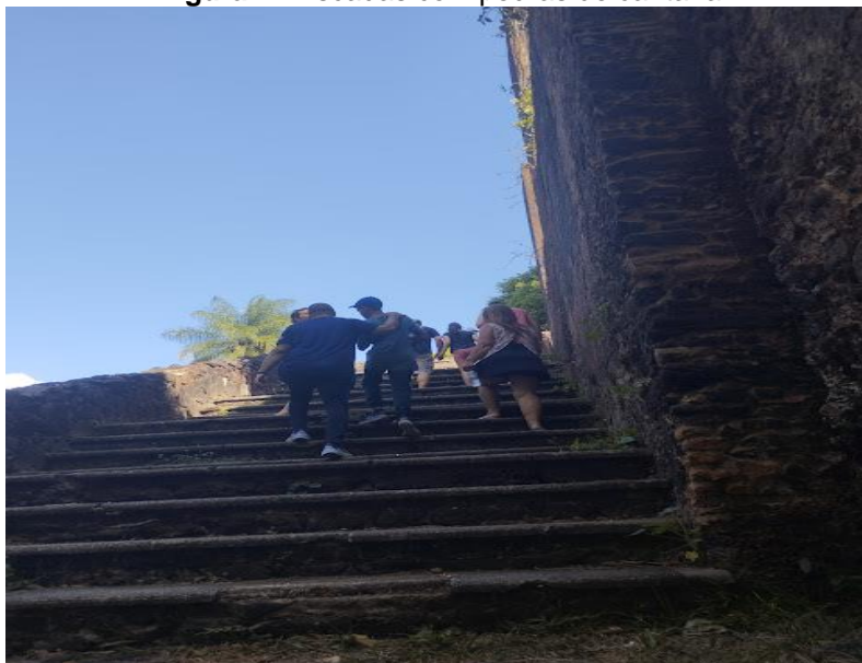
Figura 42 Escadas com pedras de cantaria
