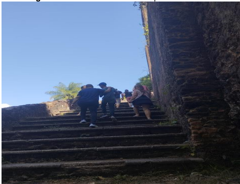
Figura 43- Escadaria de acesso à parte alta do sítio
