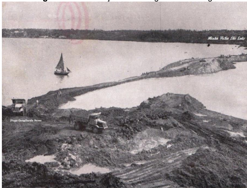
Figura 16- Construção da Barragem do Bacanga
