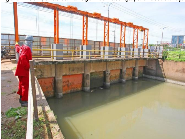
Figura 1- Comportas da Barragem do Bacanga para reestruturação
