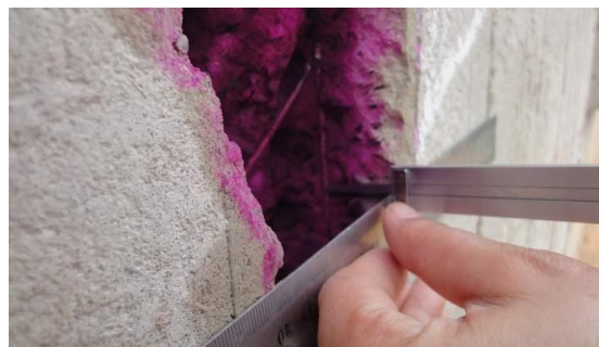
Figura 18: Ensaio de carbonatação
