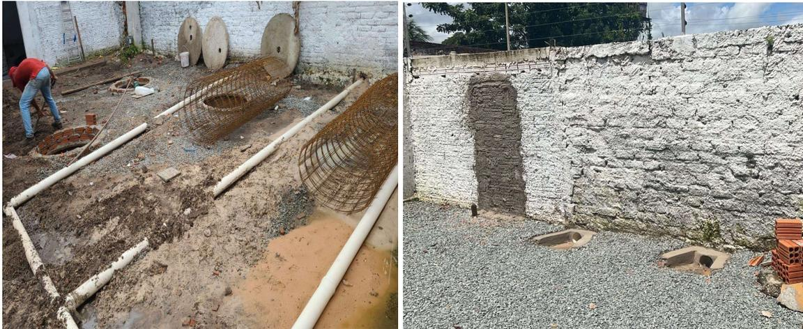
(b) Execução de drenagem pluvial em núcleo de alvenaria
