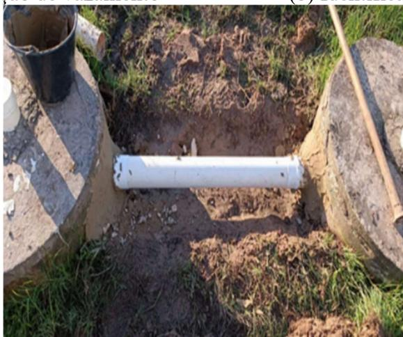
(c) Substituição de tubulação de esgoto.
