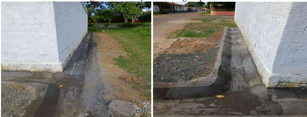
(a) Execução de canaletas em núcleo modular
