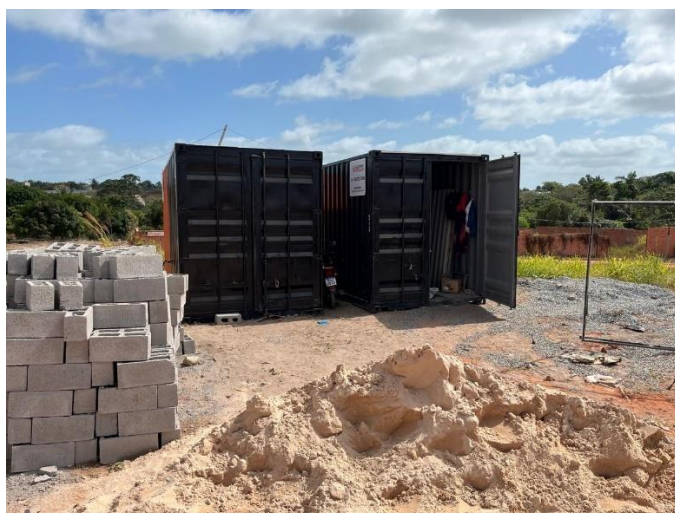
Figura 19 - Contêiner disposto no canteiro de obras
