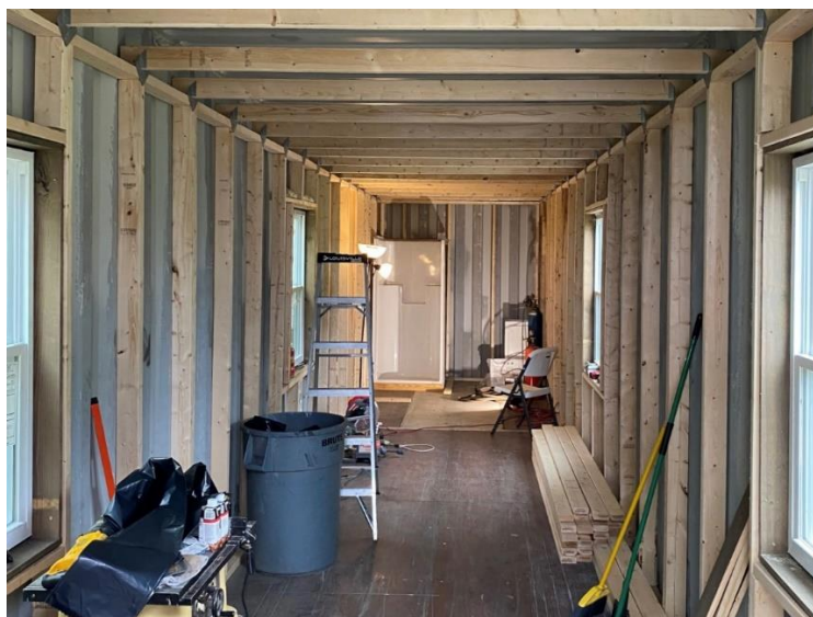
Figura 6 - Isolamento interno em contêiner
