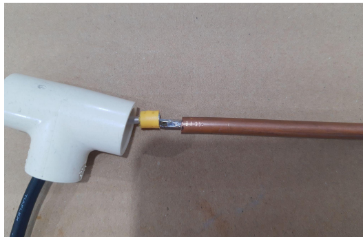
Figura 6 – Fixação do cabo no tubo de cobre
