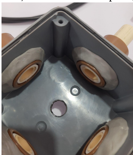
Figura 17 – Furo na caixa de passagem
