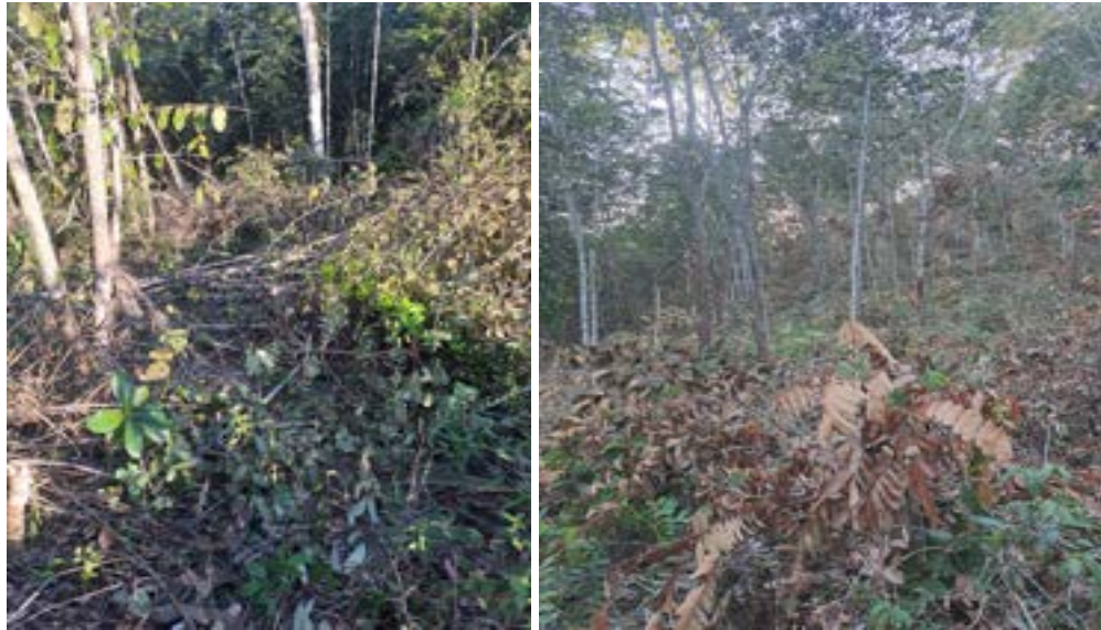
a) Limpeza do Terreno.
