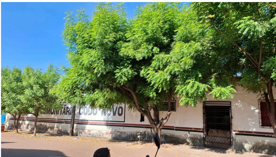
Foto 1 – Entrada da Escola Comunitária Codó- Novo
