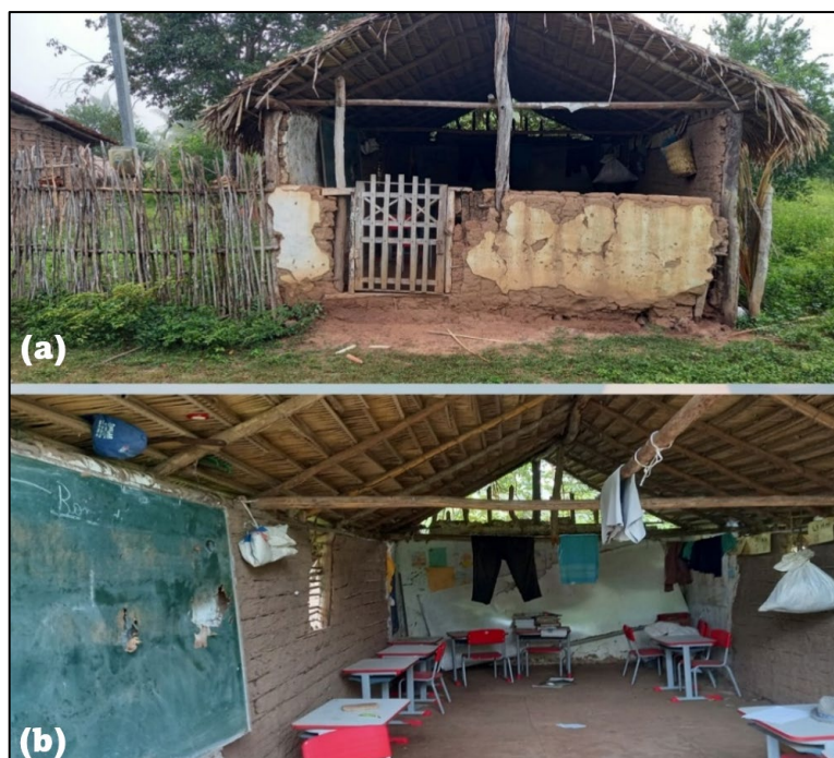
Figura 2: Escola Santa Filomena – Tanque dos Almeidas. (a) fachada; (b) estrutura interna
